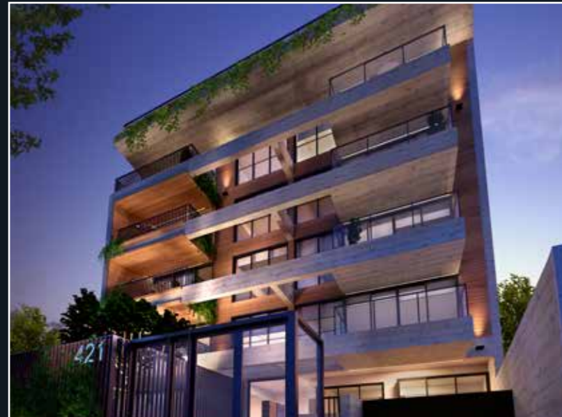
LE PARC AV. PRECURSORES 421, URB. CHACARILLA - SURCO
